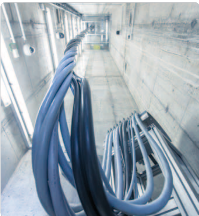
Obr. Šestnáct metrů vysoká šachta v logistické budově Lapp, která původně sloužila pro výtah je využívána pro realistickou simulaci zátěže energetického zařízení věže a gondoly větrné elektrárny.
